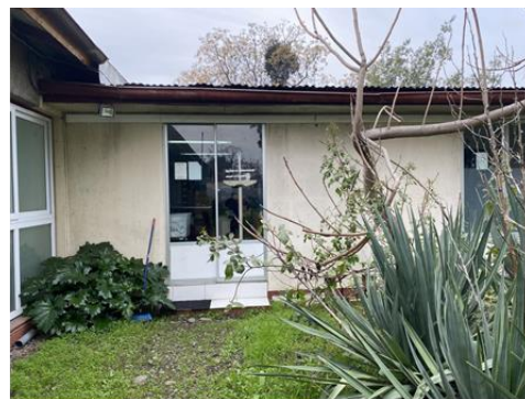
FIGURA 8: MEJORAMIENTO PISOS, VENTANAS Y CANALETAS CESFAM LA FLORIDA
